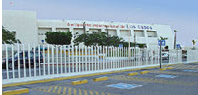
Terminal 1 San Jose del Cabo
