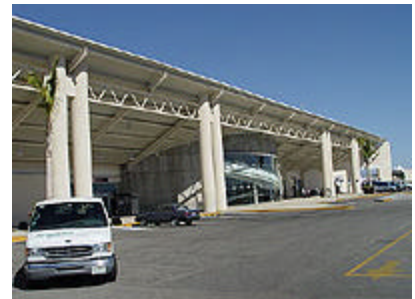
Terminal 3 San Jose del Cabo
